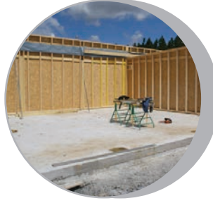
Réception, puis montage des cloisons en ossature bois
