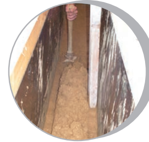
Construction du mur trombe
